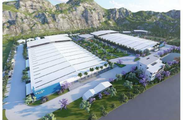
武崖 TNG 缝纫公司（第一阶段） 地址：太原省武崖县柚树工业区 投资者：TNG 投资与贸易股份公司
