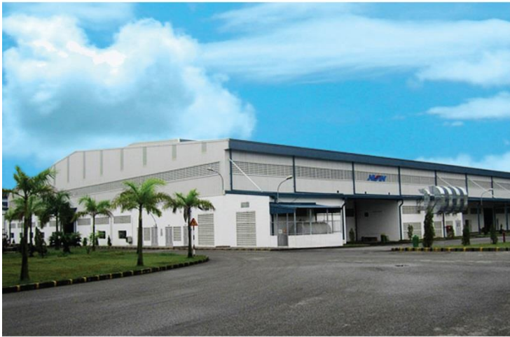
3号越南 NISSIN 制动器工厂 地址：永福省平川县桔刘社 投资者：越南 Nissin 制动器生产公司
