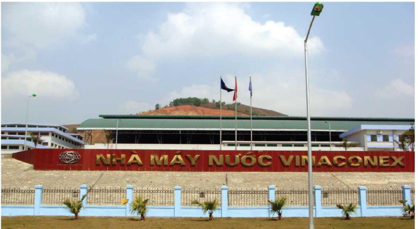
沱江水工厂（水库，滤池，混合池） 地址：河内市和平省 投资者：Vinaconex – 越南进出口与建设股份公司
