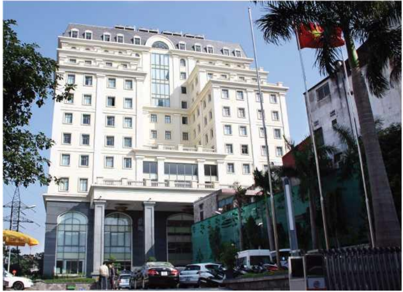
国库工作总部 地址：河内市栋多郡吉玲路 32 号 投资者：财政部
