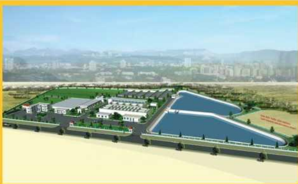
桥路与技术基础设施工程建设
