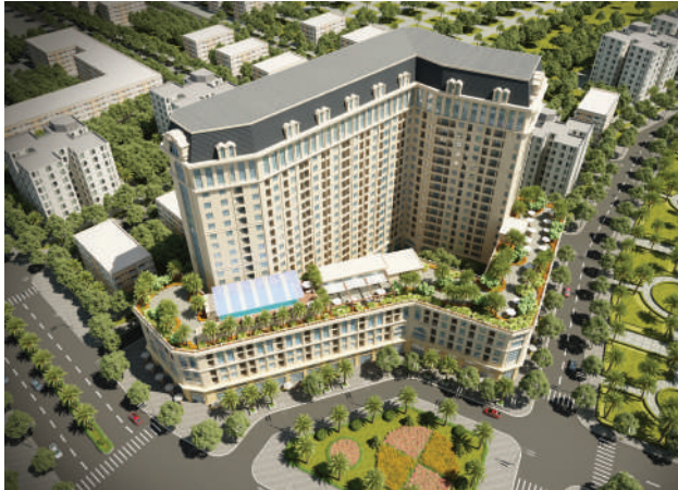
Tổ hợp căn hộ khách sạn chung cư Royal Park Địa điểm Đường Kinh Dương Vương, Phường Vũ Thu, Tỉnh Bắc Ninh Chủ đầu tư Công ty TNHH Đầu tư Châu Á Thái Bình Dương
