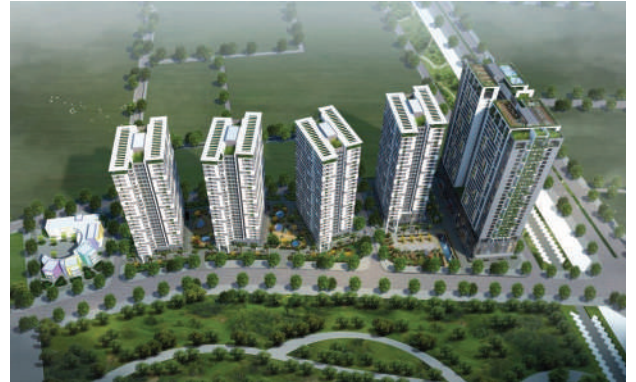
Nhà ở xã hội cho cán bộ chiến sỹ Bộ Công An Địa điểm phường Cổ Nhuế 2, quận Bắc Từ Liêm, Hà Nội Chủ đầu tư Liên danh Constrexim1 - Thái Hà
