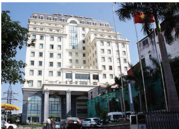
Trụ sở làm việc Kho bạc Nhà nước Địa điểm Số 32 Cát Linh, Đống Đa, Hà Nội Chủ đầu tư Bộ Tài chính
