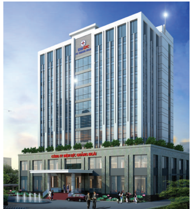
Nhà điều hành sản xuất Công ty Điện Lực Quảng Ngãi Địa điểm Số nhà 243, Đường Trần Hưng Đạo, Quảng Ngãi Chủ đầu tư Tổng Công ty Điện Lực Miền Trung
